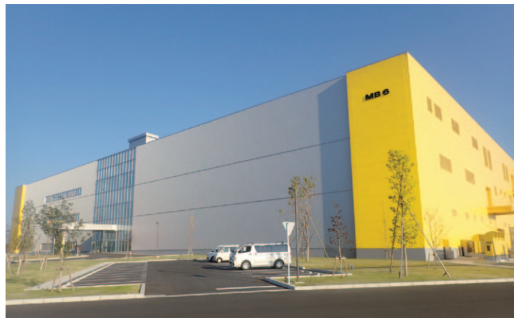
壬生レーザ工場外観
