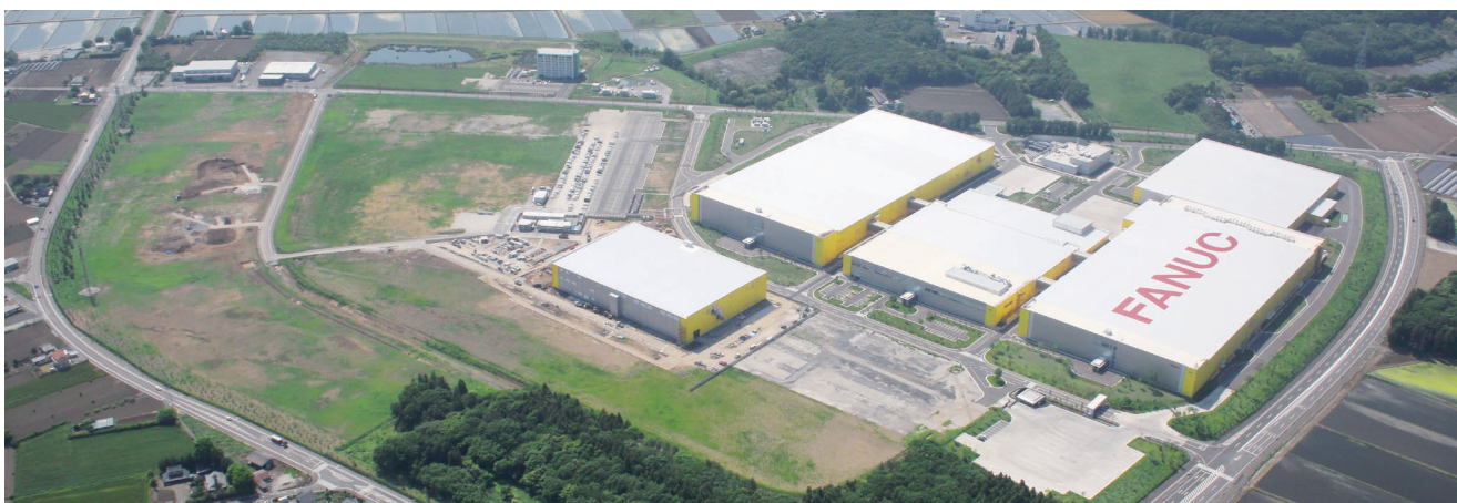
壬生工場全景
